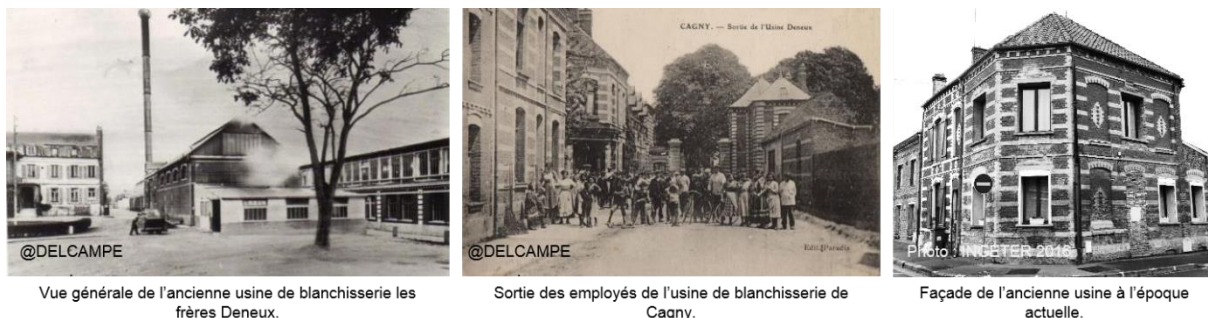
Figure 21 : Architectures industrielles de Cagny en début du XX ème siècle
