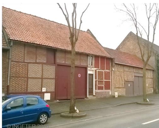
Corps de ferme à maçonneries mixtes bois et briques. Rue Jean Catelas
