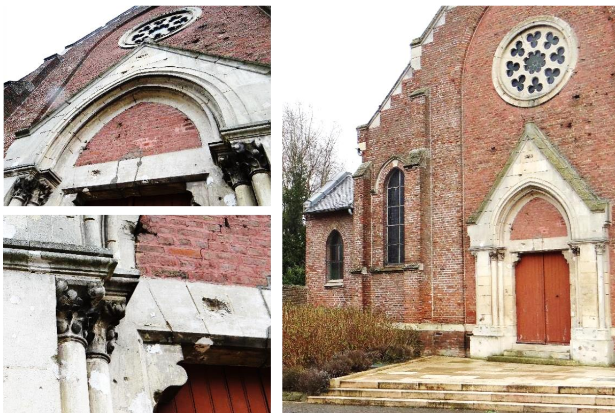
Figure 18 : Eléments remarquables de la façade principale : Polychromie due à l'insertion d'un appareillage régulier de briques ; Marquise plate en pierres tailles, vitrail rond en dalle et verre...
