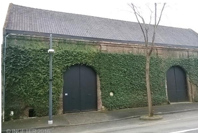
Corps de ferme: maçonneries, contreforts et corniches en briques. Rue Jean Catelas
