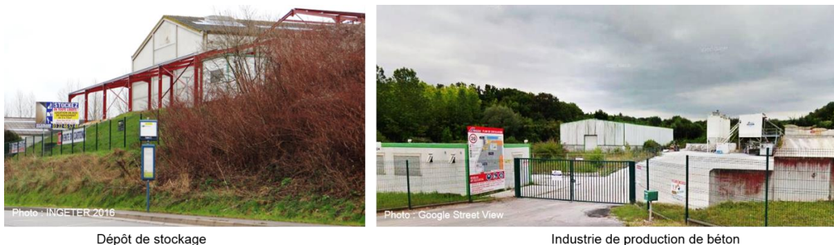
Figure 22 : Bâtiments représentatifs de la zone industrielle de Cagny, développée depuis les années 1970
