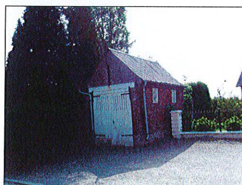
L'ancien poste à incendie
