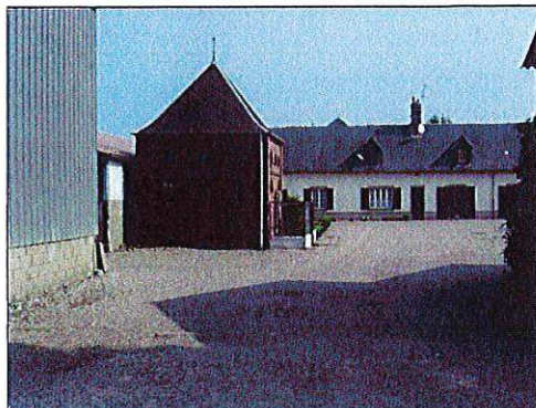
Photo 17 : Des constructions parallèle à la route, en fond de cour
