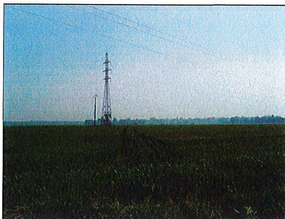
Photo 9 : Les réseaux aériens, les lignes électriques
