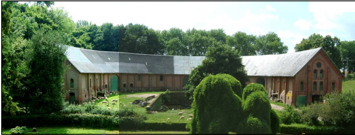
Photo 17. Ferme du Val Vion
