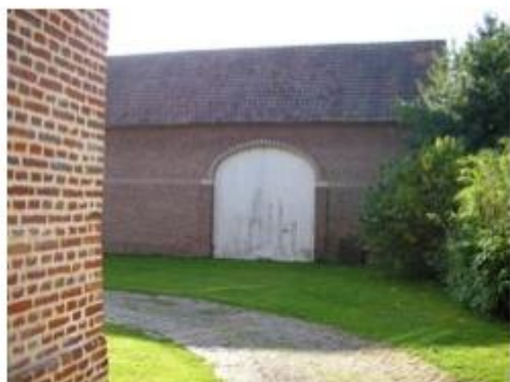
Bâtiments agricoles rue du Calre
