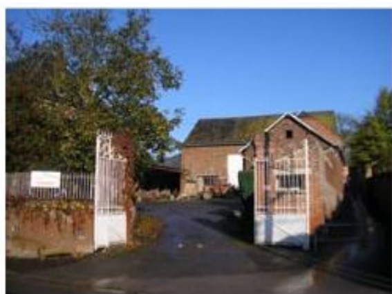
Bâtiments agricoles rue du Dessous
