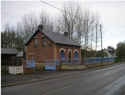
Bâtiment retrait - clôture / Route de Ham
