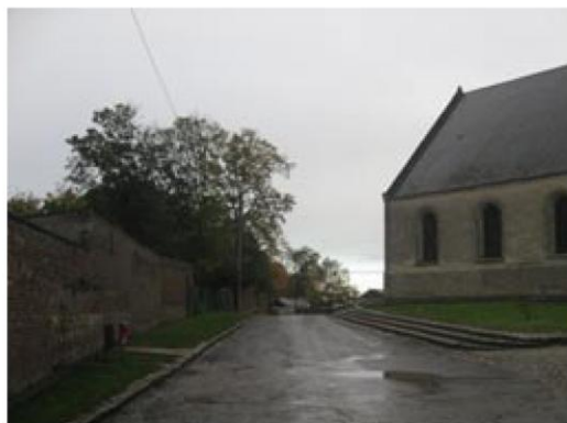
Aménagement des abords de l'église (rue de l'église)
