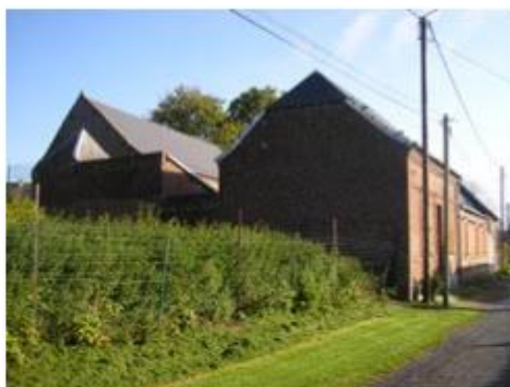
Bâtiments agricoles rue du Calre
