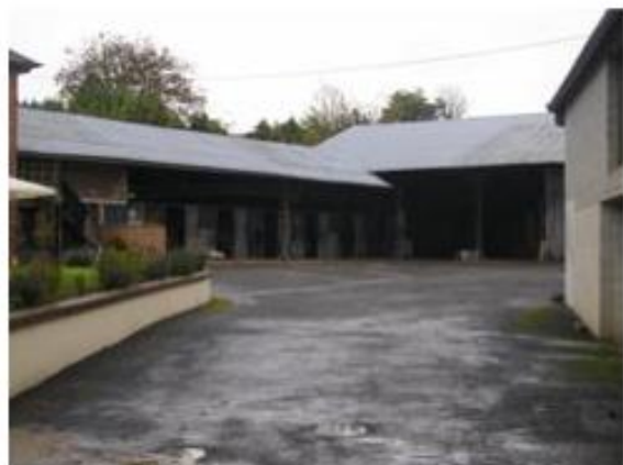
Bâtiments agricoles route de Ham
