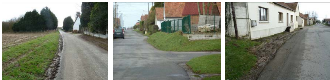
Absence de fossé et de cunette sur la rue de Lombardie et la Petite Ruelle
