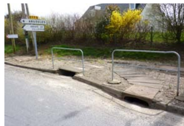
Absence d'ouvrage de collecte dans les vallées sèches en aval d'Argoules laissant entendre qu'il n'y a pas de ruissellements réguliers et perturbants. Entrée du bourg de Vron en aval du "Petit Chemin". équipé de bouches avaloires pour gérer les apports en cas d'orage.
