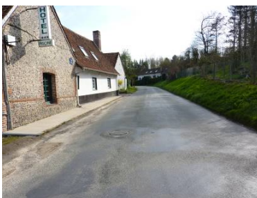
Débouché de la RD175
