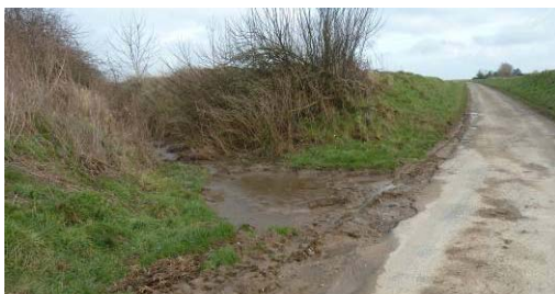
Evacuation des eaux dans un ancien chemin creux aménagé en fosse de décantation sur le plateau (BV115)
