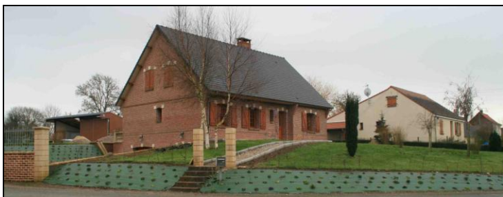
Echantillon de constructions récentes de la commune.
