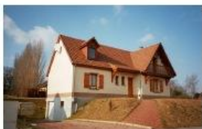
Décaissement et butte importants dégageant un pignon disproportionné; avancée de toit style «chalets»
