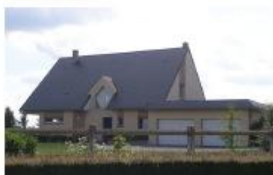
Style architectural sans référence locale, toiture terrasse de garage «pseudo-plat», portes trop blanches
