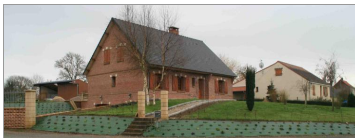
Echantillon de constructions récentes de la commune.
