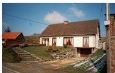
Décaissement partiel et butte; «dent creuse» (retrait) dans le front bâti; enduit blanc; menuiseries vernies
