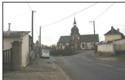
Rue et place de l'Eglise
