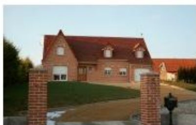
Effet «dent creuse» marqué, butte importante créant une rupture avec les toits voisins, pentes trop raides
