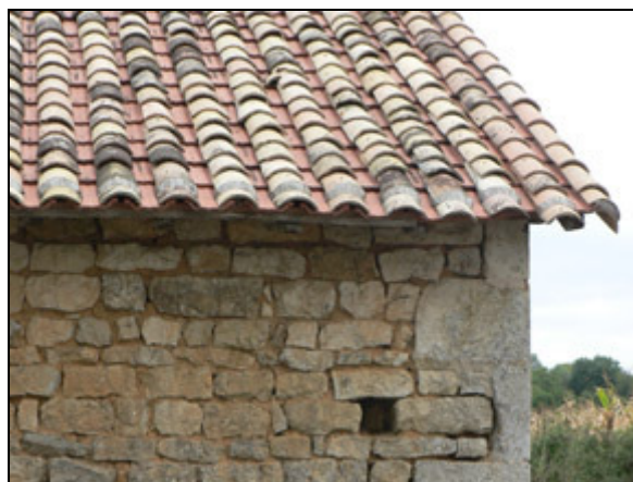
Mur en pierre calcaire taillée, couverture en tuiles « tige de botte », débordement du toit, chevrons et voliges apparents
