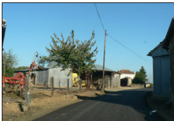
Bâtiments agricoles au Nord-Ouest du village
