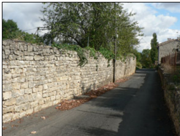
Voie d'accès aux espaces situés en arrière
