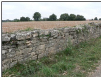
Muret en pierres sèches
