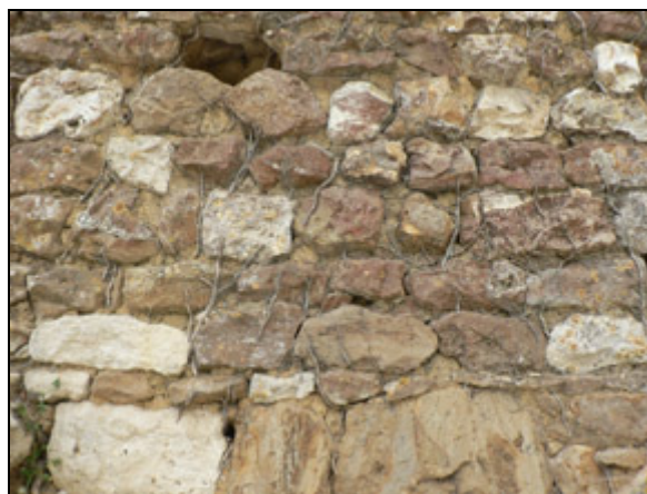
Mur en moellons calcaires et en pierres rousses de Pied-Pouzin
