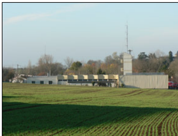
La future zone d'activités commerciale du Pinier, à proximité du centre de secours et d'incendie
