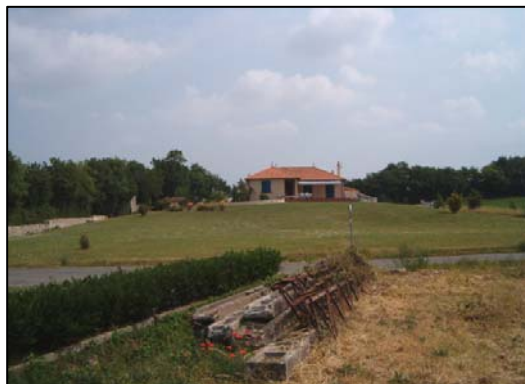
Pavillon isolé à l'entrée Est depuis la RD.740
