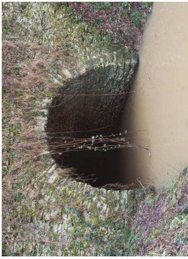
Aqueduc creusé de Vieille-Eglise
