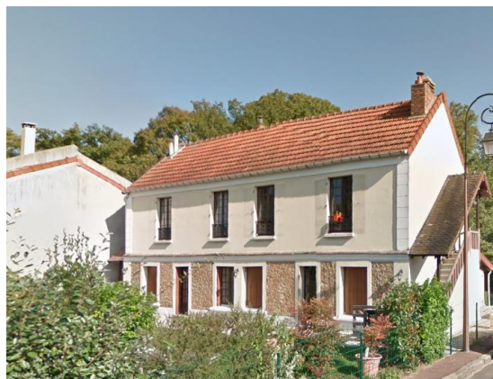
Ancien Relais de Poste
