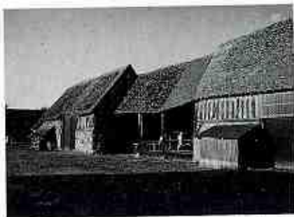
Exemple d'utilisation de pans de bois dans une ferme du Mantois.
