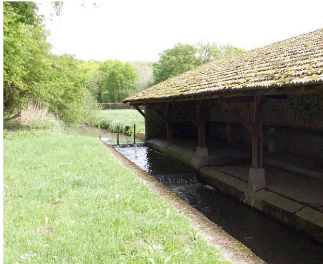
Obstacle à l'écoulement : lavoir sur la Rémarde
