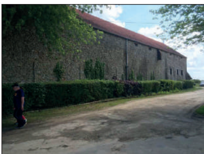
Vue du bâtiment concerné depuis l'espace public.
