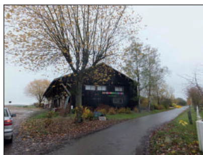
Bâtiment voisin, du même site d'exploitation, aménagé pour l'accueil de public (petits spectacles...)
