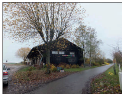
Bâtiment voisin, du même site d'exploitation, aménagé pour l'accueil de public (petits spectacles...)
