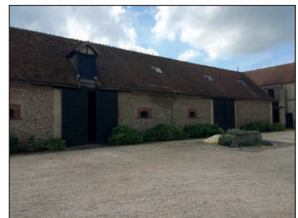
Vue du bâtiment concerné depuis la cour.
