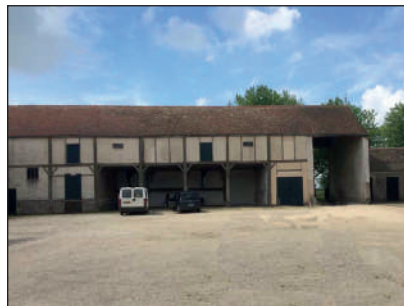
Vue du bâtiment concerné depuis la cour.
