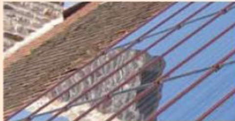
Assortir la teinte des capteurs et des profilés à celle de la toiture
