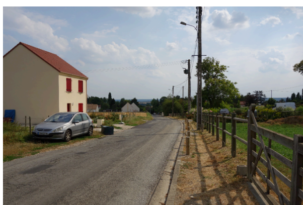
Vue 3 – Rue de la Tuilerie orientée sud
