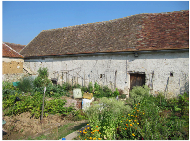
Vue 8 – Potager à l'arrière, mur en bauge sur l'un des bâtiments
