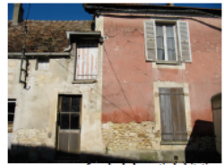
façade de la partie habitation
