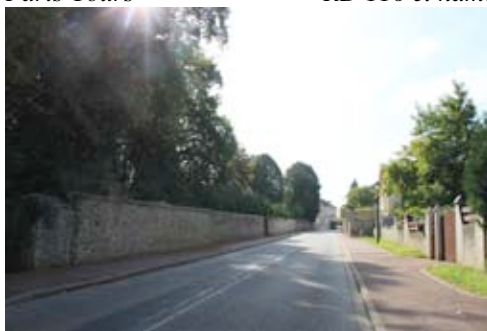
RD 116- Entrée Est St Martin de Bréthencourt
