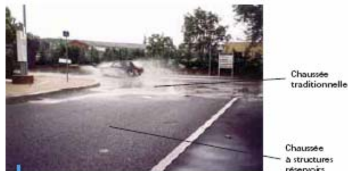
Chaussée réservoir, Craponne.
