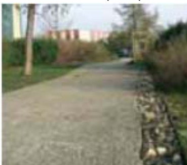
Cheminement piéton bordé d'une tranchée d'infiltration, ZAC des Chênes, Corbas
