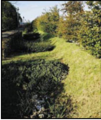
Exemple d'un fossé, où l'implantation de végétaux a été possible (fossé plus proche d'une noue)
