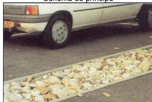
Tranchée sous enrobé drainant, longeant la voirie (Eysines-33).
