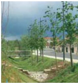
Noues cloisonnées, Parc Bouglione, Corbas
