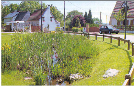
Recueil des eaux pluviales par noue engazonnée
