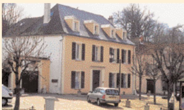
L'ardoise est adaptée aux fortes pentes. ▼
