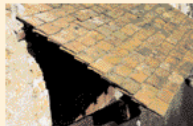
▲ Auvent d'un lavoir privé. Le recouvrement des tuiles est seulement de moitié.
