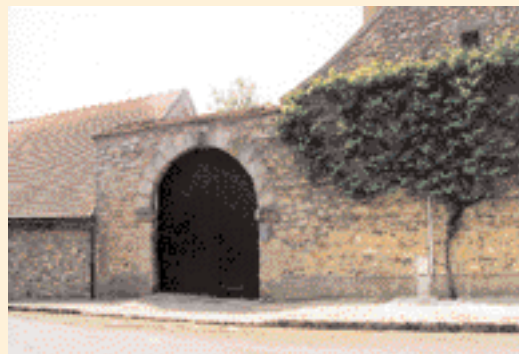
▲ Le mur est à la dimension de la porte charretière.
