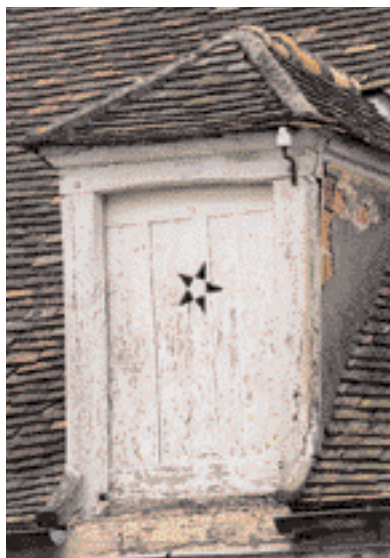
▲ Cette lucarne dite à la capucine* (toit à trois pans*) permettait l'accès aux combles et leur aération.
