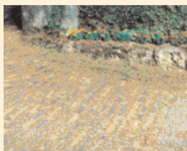
La brique posée sur chant est une belle matière adaptée à l'accès des piétons ou des voitures. ▶
