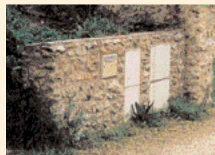
▲ Lors de la conception des clôtures il faut prévoir l'intégration des équipements techniques. On peut aussi placer les coffres, en retrait dans le mur, derrière un portillon en bois en façade.
