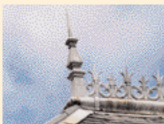
◀ Epi de faîtage et crête en zinc.
