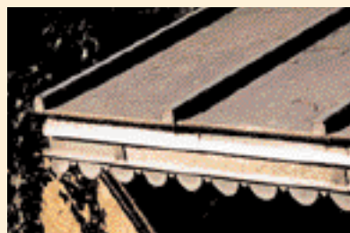
◀ Auvent en zinc d'un lavoir privé.
