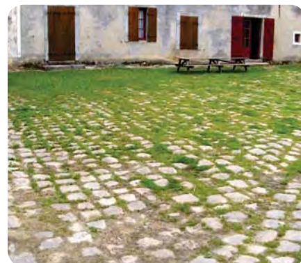
LES PAVÉS SANS JOINT LAISSENT S'INFILTRER L'EAU
