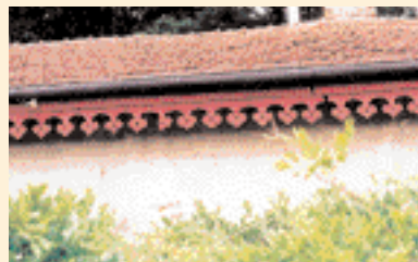
Frise en bois soulignant l'égout. Des détails remarquables à conserver. ▶
