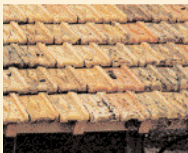
Tuile à emboîtement losangée fabriquée localement. ▶
