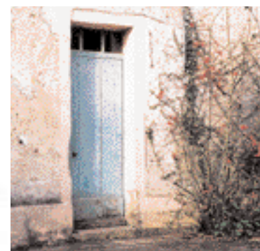
Une bande-plate* lisse en enduit souligne discrètement l'ouverture de la fenêtre. ▼
