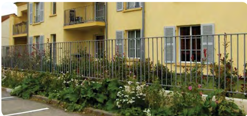
CLÔTURE PENSÉE AVEC L'ARCHITECTURE
