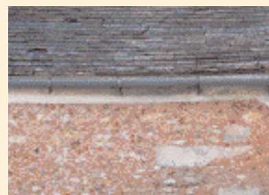
Enduit coloré à la brique pilée. ▼
