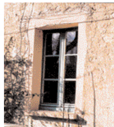
Une bande-plate* lisse en enduit souligne discrètement l'ouverture de la fenêtre. ▼
