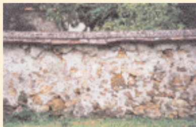
▲ Mur plein en maçonnerie de meulière.
