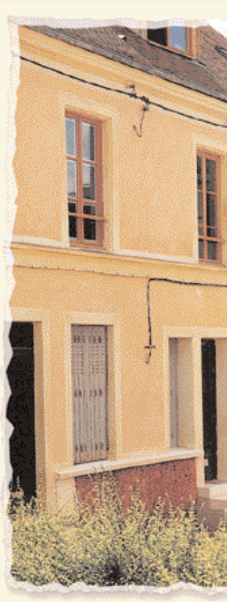
▲ L'enduit couvrant doit être conservé en évitant de mettre à nu la pierre.
