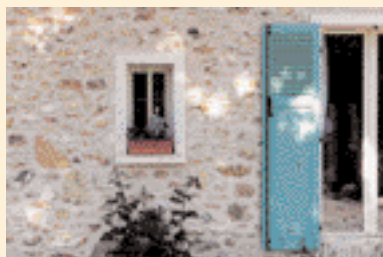
Enduit à pierre vue. ▲
