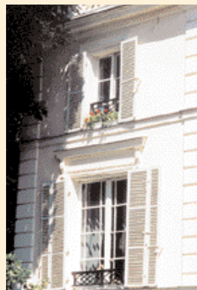
▲ Le décor crée des jeux d'ombre sur la façade.
