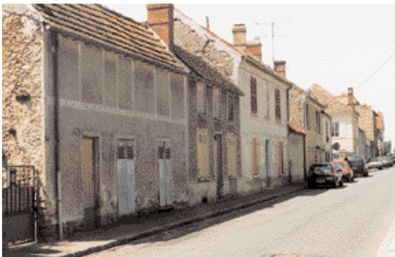
L'alignement sur la rue est rigoureux, les hauteurs varient. ►
