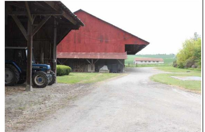
Vue sur les bâtiments d'exploitation du Domaine Pasteur (1e moitié XXe siècle), servant au rangement du matériel et stockage
