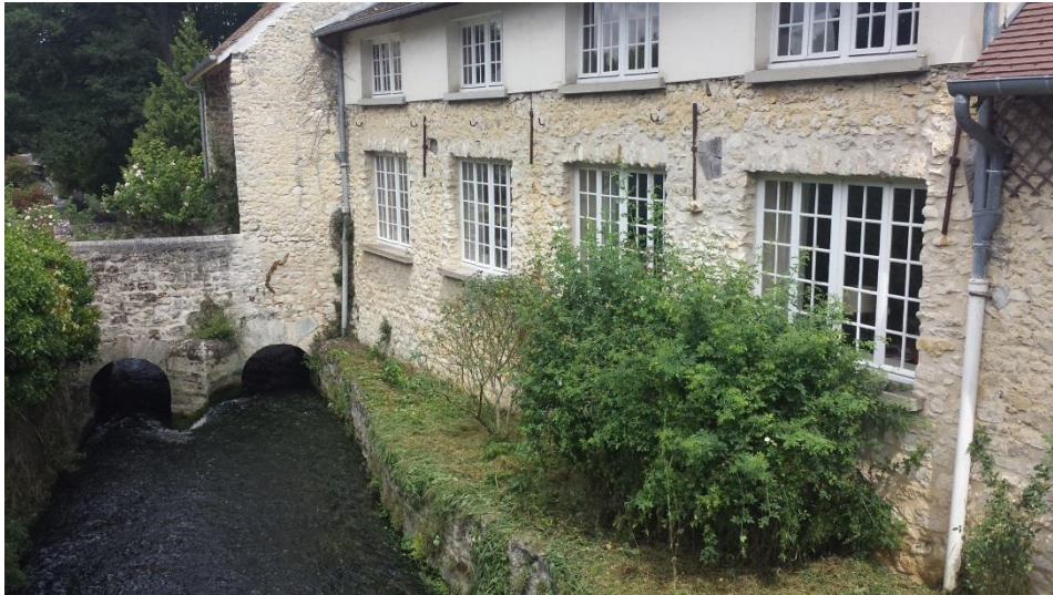
Le passage du ru de Gally au niveau de Rennemoulin montre un «étranglement» ancien, renforcé par le comblement de l'ancien bief laissant un unique passage au niveau des ponts existants.
