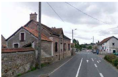
Ferme située avenue de Paris, en entrée de ville
