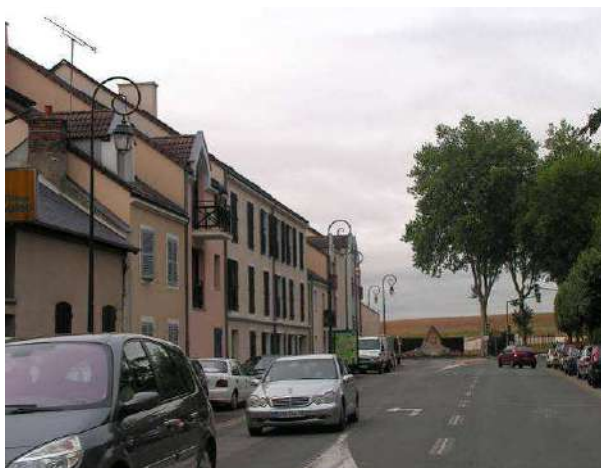
Petits collectifs récents avenue du Maréchal Leclerc ; en arrière plan, les espaces agricoles de la commune de Gazeran
