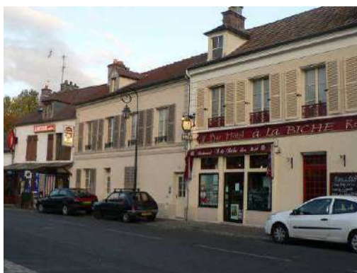
Le bâti ancien aux abords de la rue de Groussay
