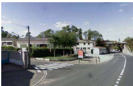
Rue Gosselin Lenôte : l'entrée du site des services techniques qui accueillera bientôt un important programme de logements collectifs
