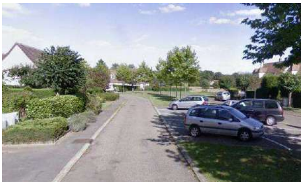
Tissu pavillonnaire rue Franz Schubert ; en arrière-plan, le site d'accueil de construction de logements « la 11 e tranche »
