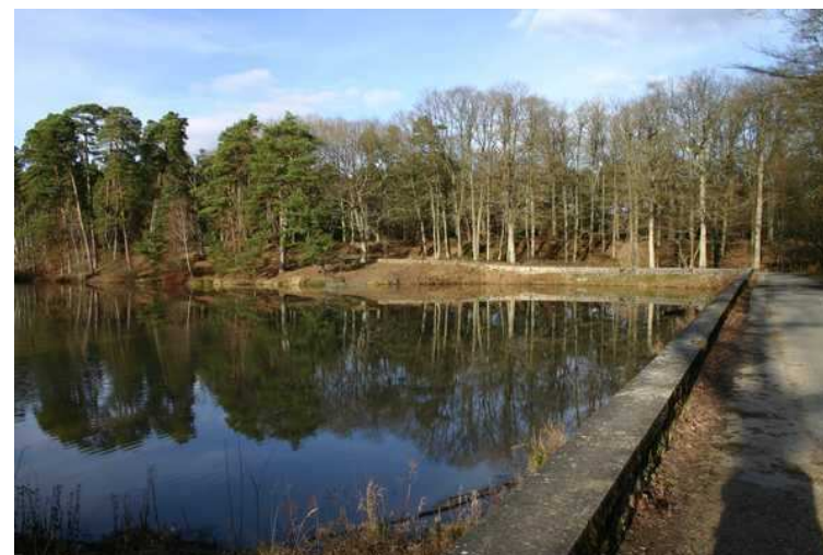
Digue de l'étang de Coupe-Gorge
