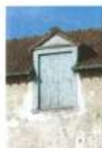
lucarne fenière, deux versants, engagée dans le mur.
