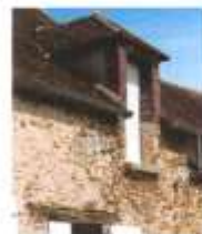
lucarne à capucine, trois versants, engagée dans le mur.
