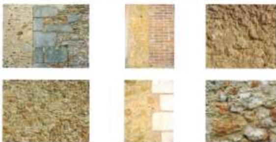
Matériaux rencontrés dans les Yvelines moellons calcaire, meulière, brique, pierre de taille, grès...
