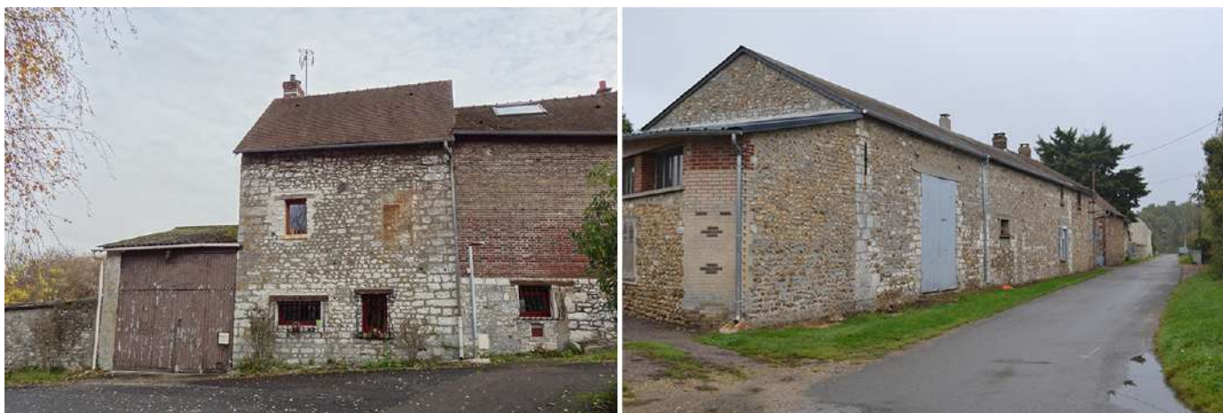
exemples de maçonneries locales
