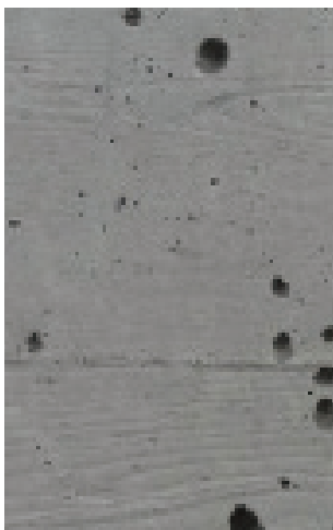
Béton brut de décoffrage
