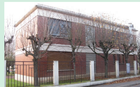
Ancien bâtiment d'entrée (en projet de réhabilitation)
