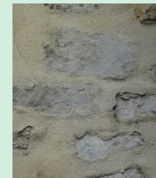
Enduit à pierre vue posé à fleur de parement, teinté dans la masse par adjonction de sables locaux
