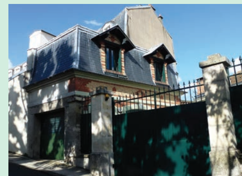
Construction à comble brisé couverte en ardoises
