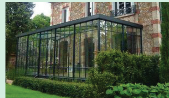
Véranda en acier sur façade en meulière
