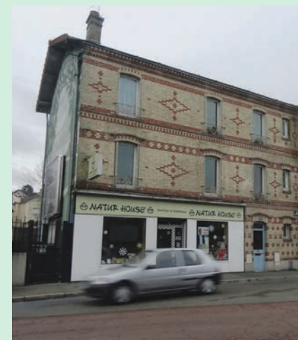
Richesse de l'emploi de la brique pour les façades ou des éléments de modénatures.
