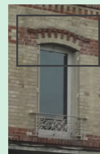
Exemple d'un linteau en arc segmentaire
