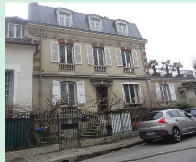
Parement en pierres de taille appareillée et décors en briques
