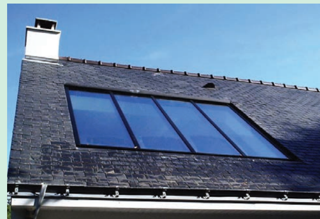
Exemple de verrière bien intégrée à la couverture, sans saillie.
