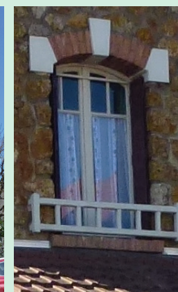
Détail en brique sur façade en meulière
