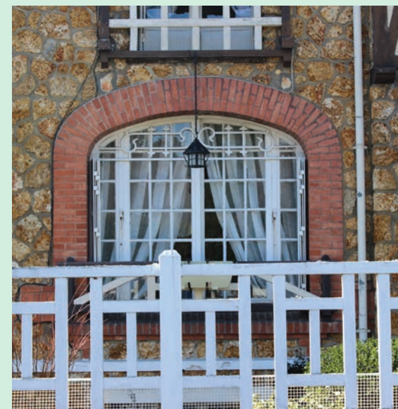
Fenêtre à petits carreaux, persiennes repliables en tableau
