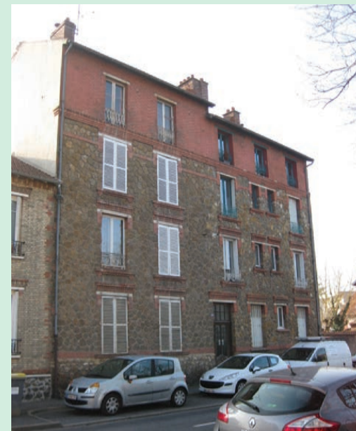
Façade avec parement mixte en briques et pierres meulières.
