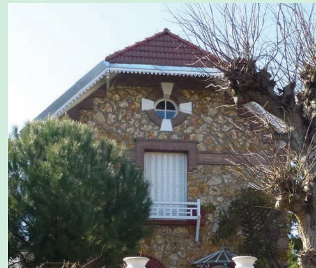
Parement en pierres meulières et décors en briques et enduits
