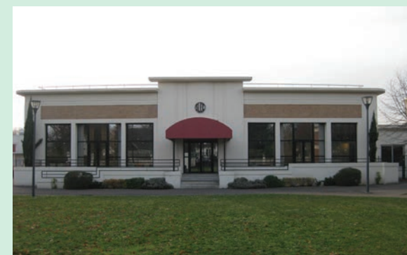
Première usine de la S.L.E.E. (restaurant d'entreprise)
