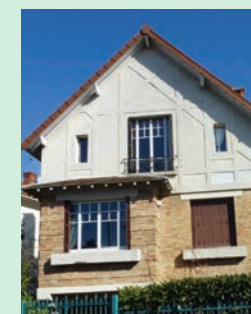
Faux pan de bois en enduit
