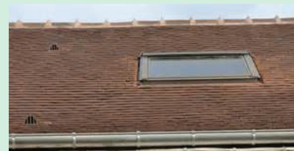
Châssis de toiture intégré à la couverture sans saillie
