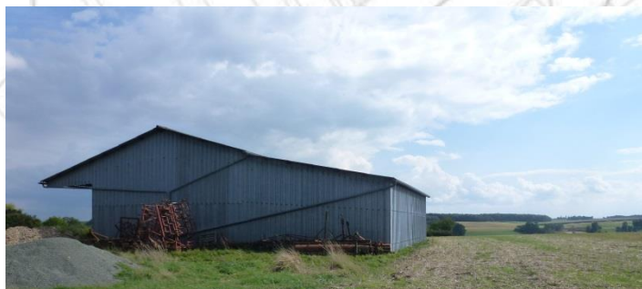
Constructions de hangars agricoles sur le plateau
