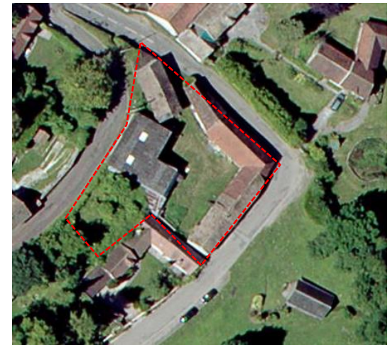
Corps de ferme rue de la Fontaine du Manet
