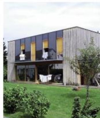
Les capteurs posés verticalement participent pleinement de la composition de la façade. Maison individuelle à Wofurt (Vorarlberg, Autriche) © CAUE 78
