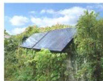
Les capteurs thermiques sont adossés à un mur du jardin. Cette solution demande une surveillance de la croissance de la végétation pour éviter toute ombre portée. Vigry (Val d'Oise) © PNR du Vexin français
