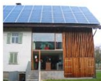
Un ensemble de capteurs recouvre toute la surface du toit, comme une nouvelle couverture. Crèche à Zwischenwasser (Vorarlberg, Autriche) © CAUE 78
