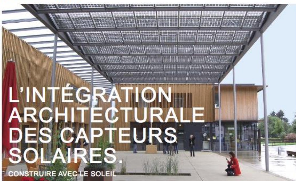
Un vélum de capteurs photovoltaïques abrite une place publique. Ludesch (Vorarlberg, Autriche) © CAUE 78
