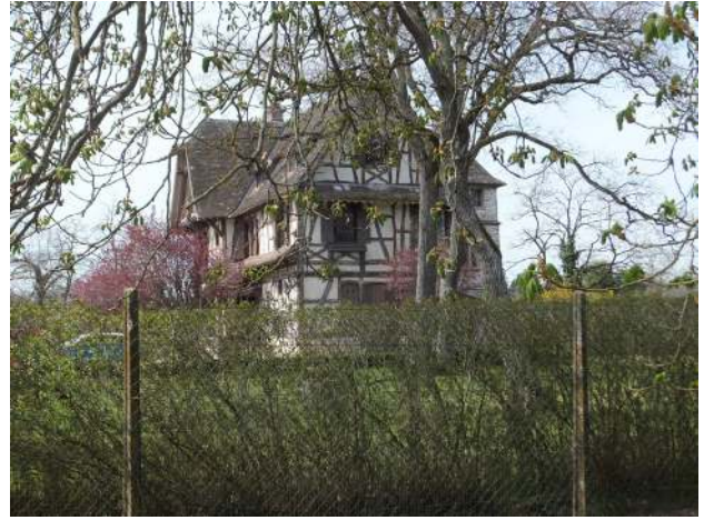
2 -Maison de notable dite le chalet
