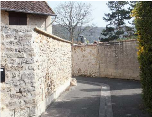
Qualité des murs à Moisson
