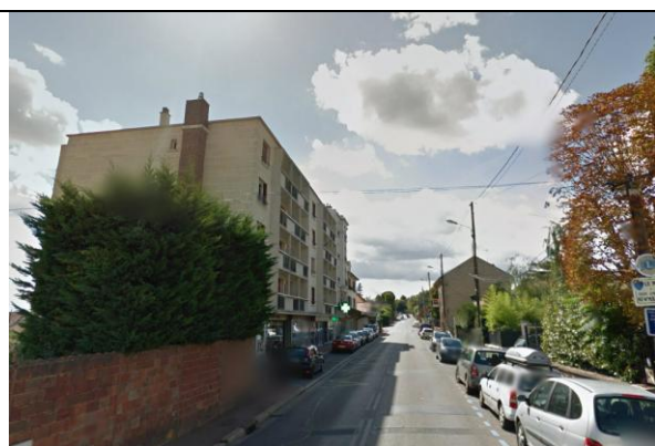
Immeuble collectif Rue de la République
