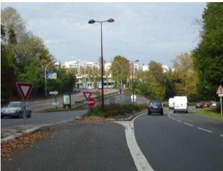
Passage depuis la RN 186 vers le quartier des Ormes
