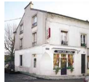
Le mur caisson des anciens magasins, source : Tigris / Flohic Editions, œuvre collective
