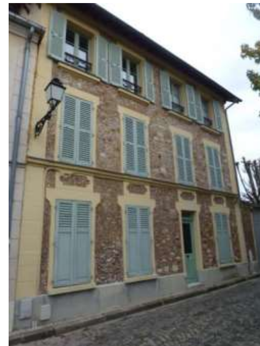
La pierre meulière est issue de la géologie locale. Elle a été fortement employée pour les constructions, notamment dans le Village
