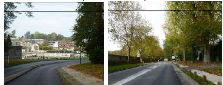
Entrée de ville depuis la RD 386
