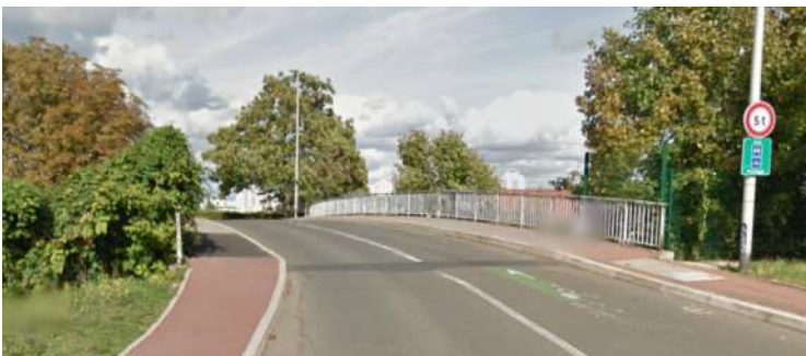
Passage aérien rue du Champ des Oiseaux, source : google maps.fr
