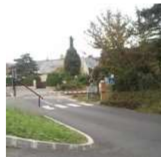
Passage à niveau en limite de l'Etang-la-Ville
