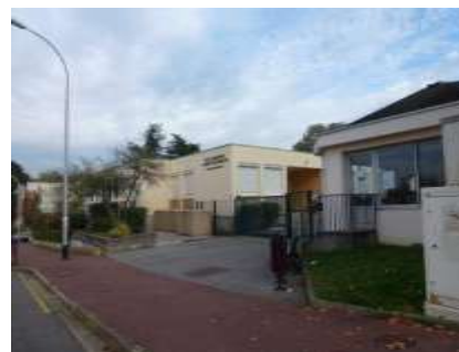
Groupe scolaire Rostand
