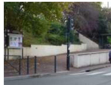
Entrée du franchissement sous la gare
