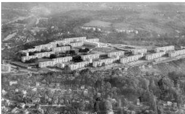
Vue aérienne des Grandes Terres - Source : fond photographique Marcel Lods
