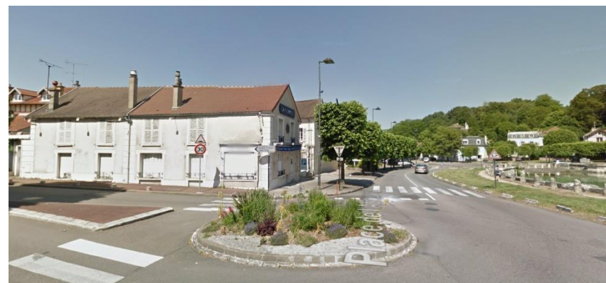
Le bâtiment d'angle « la Tempête » est préservé dans le cadre de l'OAP.
