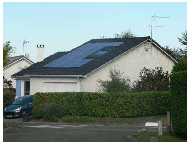
Potentiel solaire exploité par des capteurs photovoltaïques, ici au Parc de Mareil
