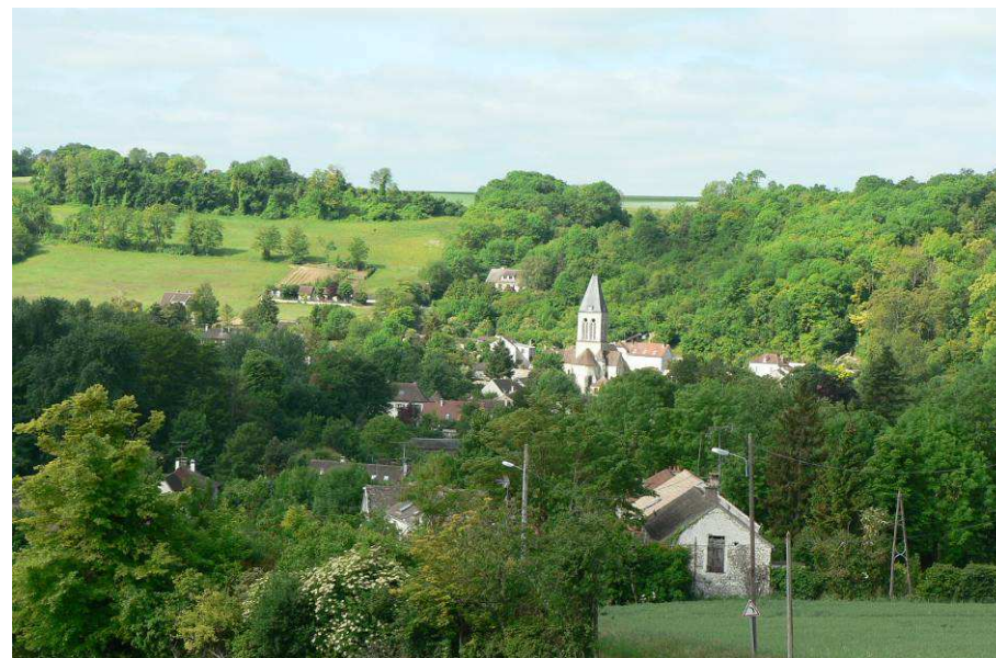
Le coteau ouest vu depuis la route d'Herbeville
