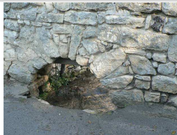
Les roches calcaires sont utilisées comme blocs à maçonner dans les constructions anciennes.
