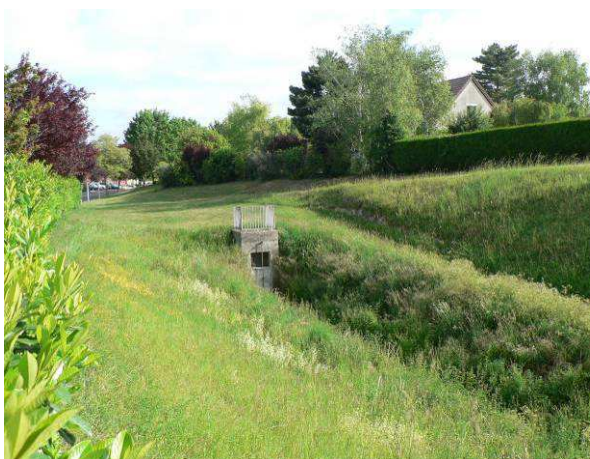
Le bassin de collecte et d'infiltration des eaux pluviales du Parc de Mareil
