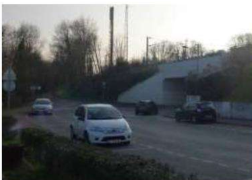
« Pont-rail » au niveau de la gare
