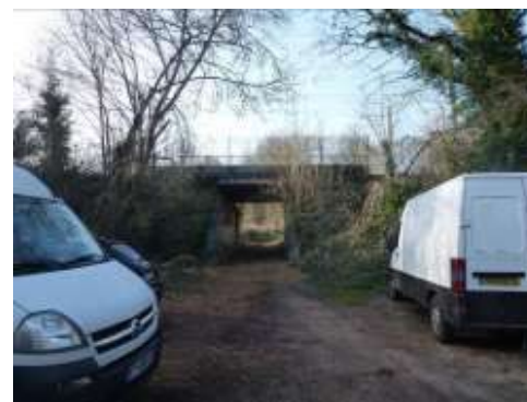
« Pont-rail » des Marivaux
