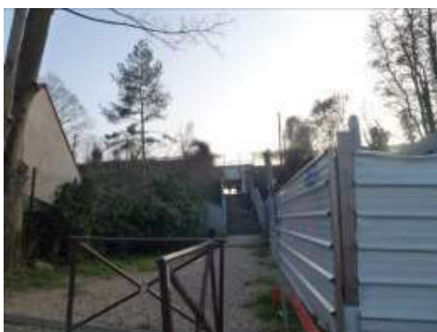
Passage souterrain chemin des Groux de la Selle
