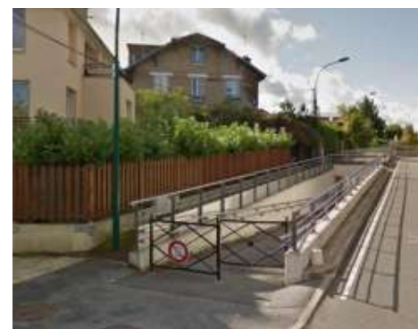
Passage souterrain route de Fourqueux
