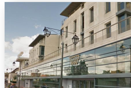
Locaux d'activités Rue Mermoz
