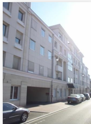
Locaux d'activités Rue Guynemer
