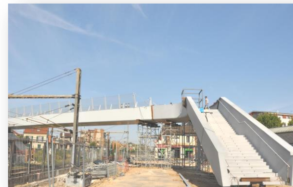
Passage de la voie ferrée du marché
