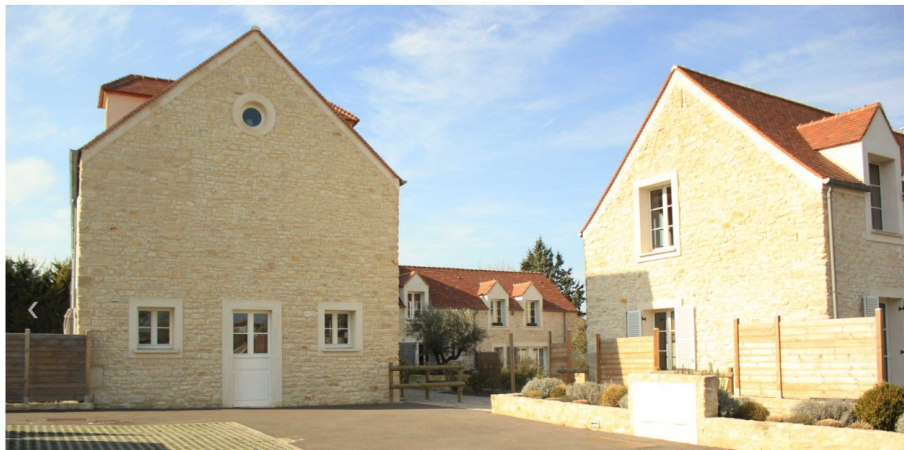
Les fermes de Chavenay (source : tribatconstructions.com)
