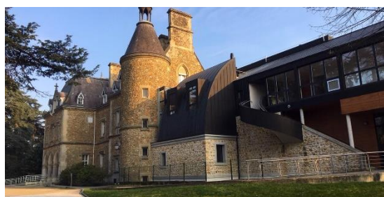
Source: Centre Pédiatrique des Côtes
