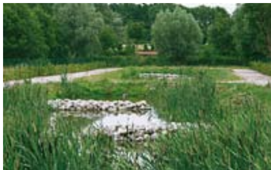
Bassin de lagunage
