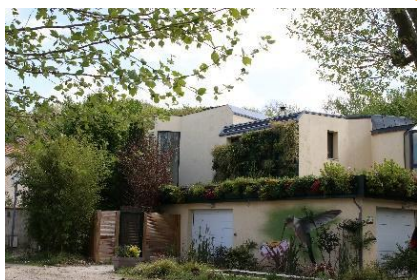
>> Construction contemporaine sur la commune © Ville de Jouars-Pontchartrain
