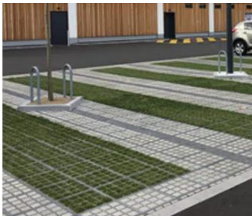
Exemple de bandes de roulement (à gauche) et de revêtement perméables (dalles alvéolées à droite) pour les espaces dédiés au stationnement
