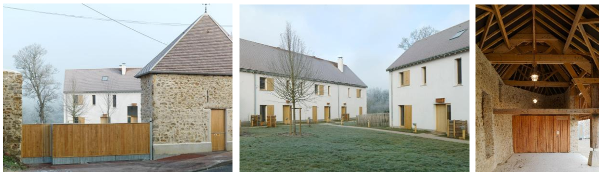
>> 10 logements individuels groupes en béton de chanvre (dont 2 sociaux), Dumont Legrand architectes, les Loges-en-Josas (78) © Cyrille Weiner
