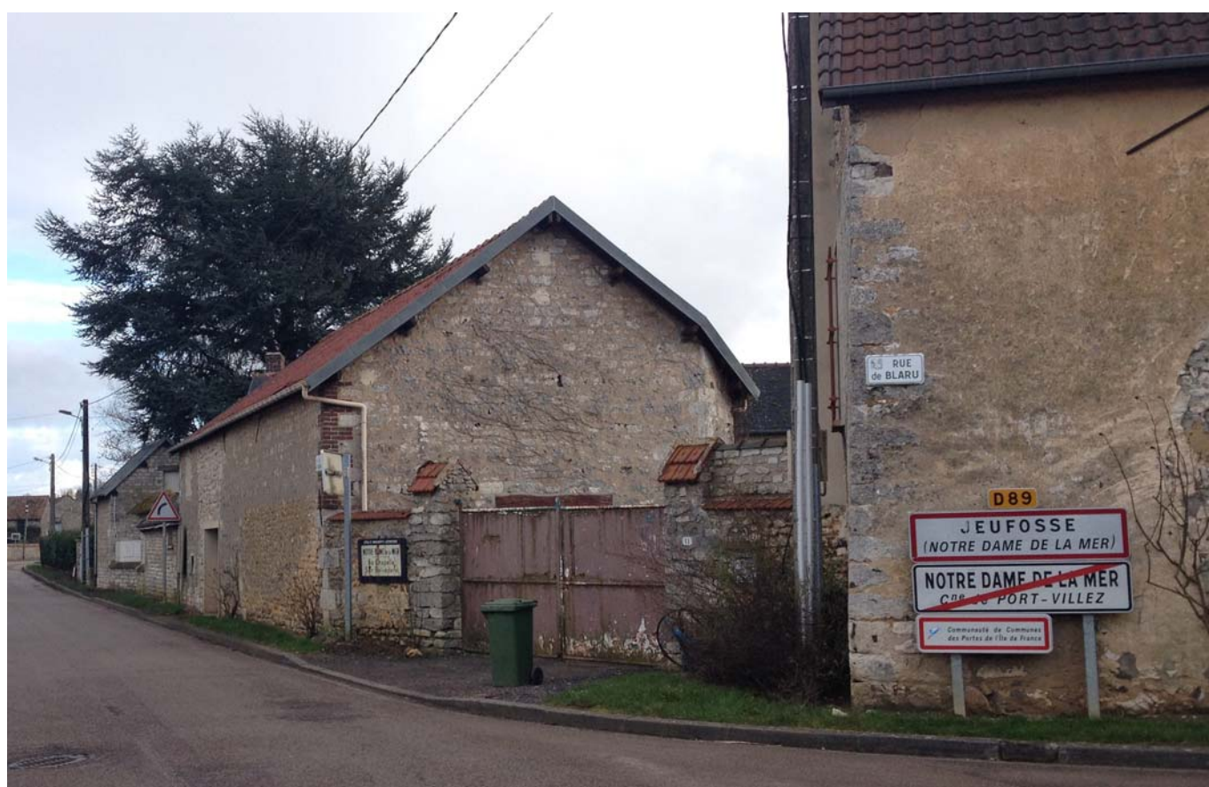
exemples de maçonneries locales
