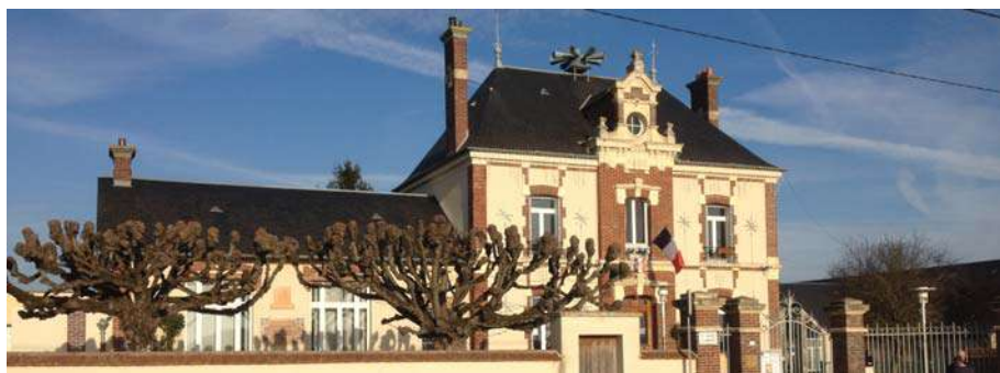
La mairie , située à la Haie de l'Écu, est un bâtiment facilement repérable en venant de la Haie de Béranville, au style architectural caractéristique des mairies franciliennes du XX e siècle.
