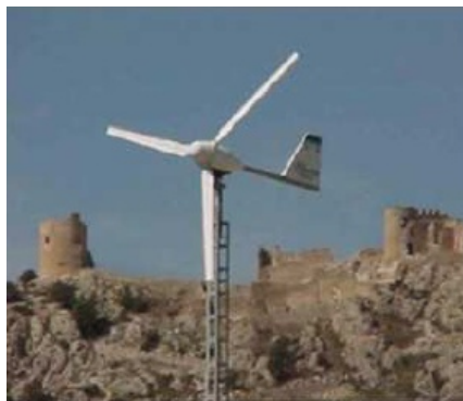
Aérogénérateur à axe horizontal
