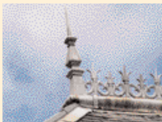
◀ Epi de faîtage et crête en zinc.
