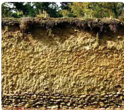
UN DES RARES MURS EN TERRE CONSERVÉ
