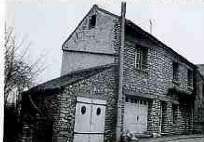
les linteaux en saillie sur la façade, les joints en creux ou en saillie,
