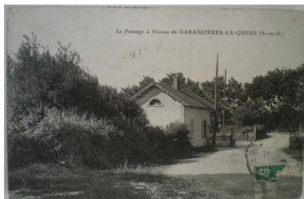
Passage à niveau Garancières la Queue
