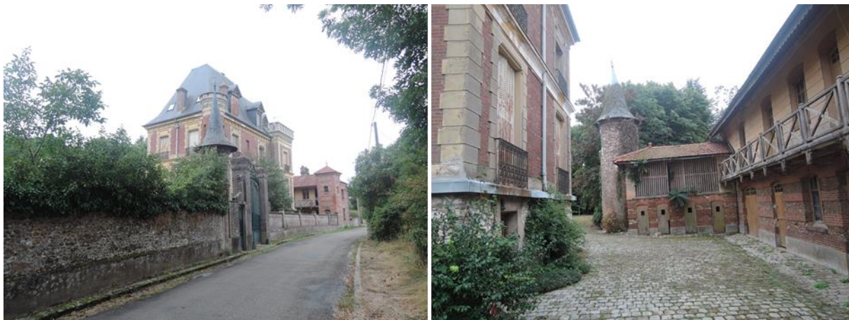
Le « château » : le bâtiment central, les annexes, le mur de clôture...
