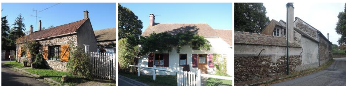
Un bâti ancien caractérisé par l'usage de matériaux locaux
