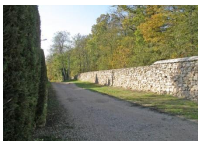
Mur, chemin du Clos Lardé
