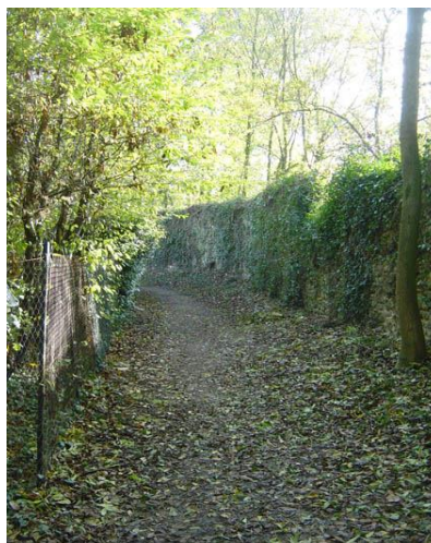
Mur, gare de Saint-Nom-la-Bretèche
