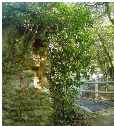
Mur, chemin de Chevaudeau
