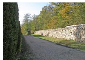
Mur chemin du Clos Lardé
