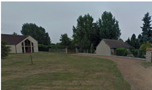
Entrée sud du site
