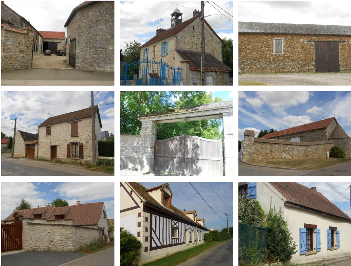
Une unité forte dans le bâti ancien du fait de l'emploi de matériaux peu nombreux
