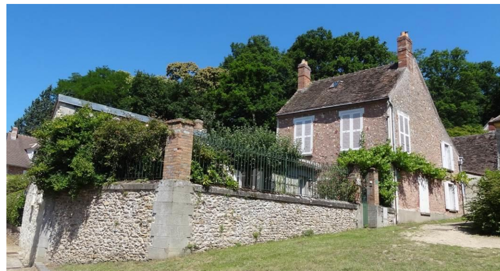
La maison de bourg d'intérêt patrimonial, on peut remarquer le modelé de sol du jardin retenu par un ouvrage de soutènement soigné, formant mur de clôture.
