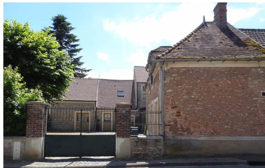
Traitements et effets des enduits qui soulignent, de manière simple, les éléments d'architecture : corniche, encadrement de baie, soubassement, chaînes d'angle.
