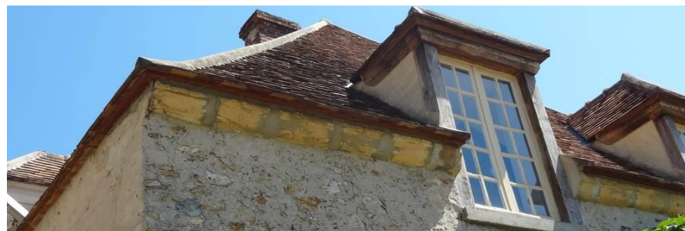
Les éléments de toiture à préserver : formes, matériaux, décors, lucarnes et souches de cheminée.
