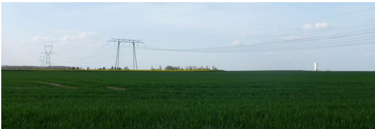
Lignes électriques en plein champ
