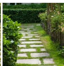
Pavés à joints enherbés
