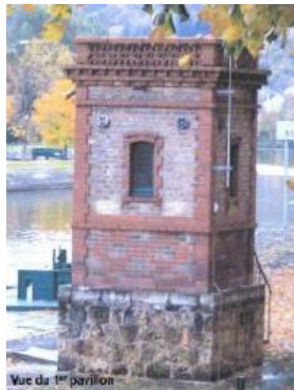
Pavillon de la première écluse
