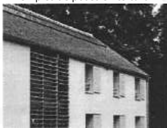
Exemples de poses en toiture
