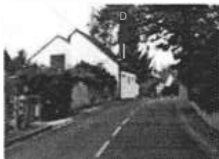
Capteur à tube en vertical côte un mur
